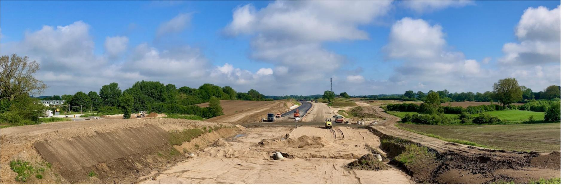
Blick von der Brücke Kirchbarkau/Fiefhusen in Richtung Klein Barkau: Die Asphaltierungsarbeiten schreiten voran. Die Fortsetzung der Trasse unter der Brücke hindurch wird noch für dieses Jahr angestrebt. Dazu muss noch der große Hügel hinter der Brücke abgetragen werden. Das abgetragene Erdmaterial soll gleich für notwendigen Lärmschutzwälle genutzt werden.
