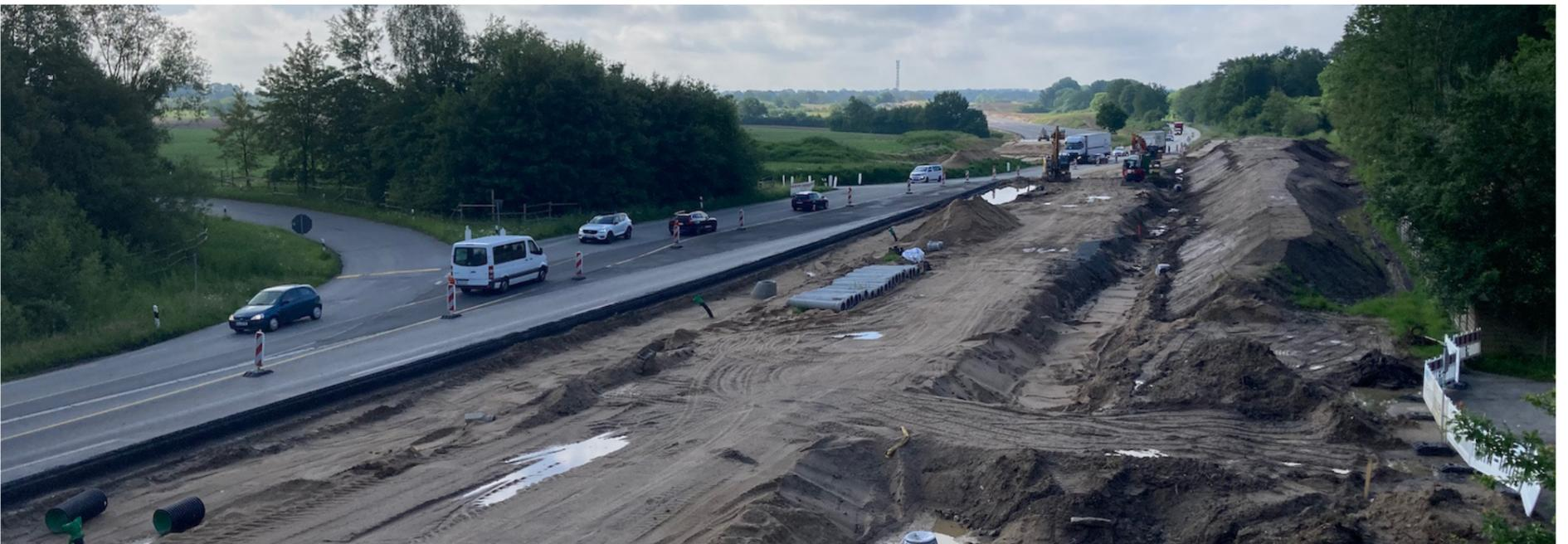
Blick von der Autobahnbrücke Klein Barkau in Richtung Segeberg: Man erkennt hier die Arbeiten an der neuen AS Klein Barkau West. Entlang des Alten Bahndamms am Grundstück Friedrichsen wird schon der Lärmschutzwall präpariert.
